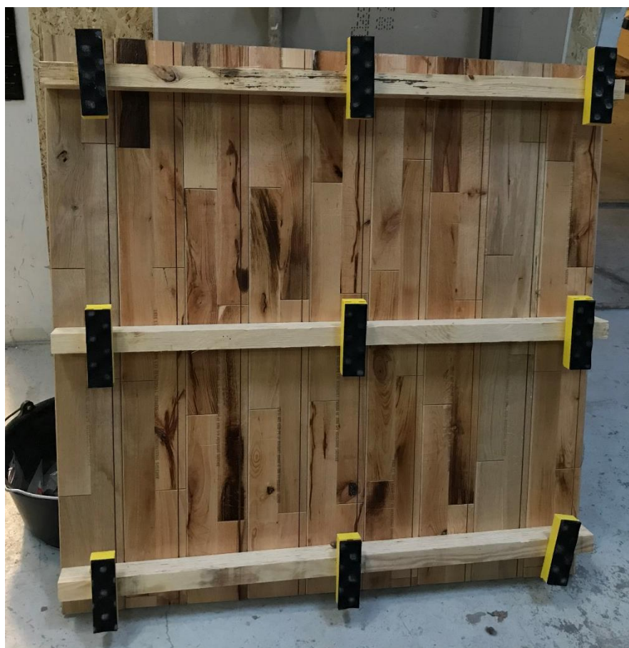
Figur 3 Bunden af gulvkonstruktionen af Gule kiler med lydbrik (dog uden isolering).
